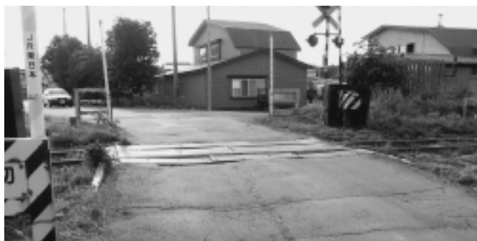
大型車両の往来が多く狭くて危険な桧木踏切
