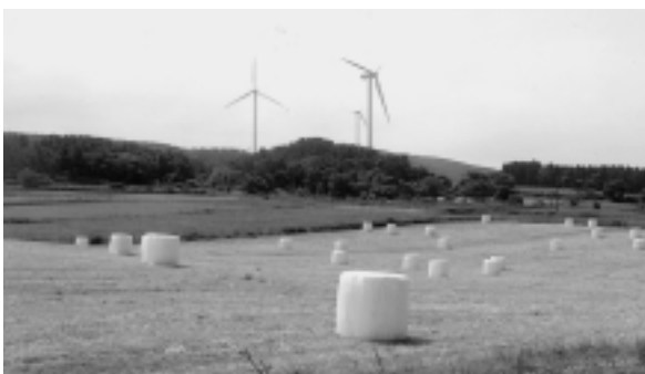
再生可能エネルギーとして注目される風力発電
