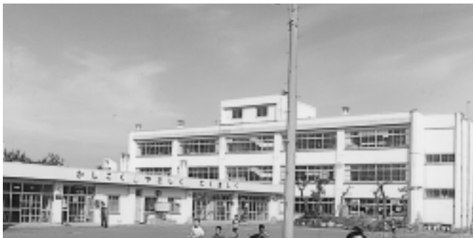
耐力度調査により危険改築が求められている横浜小学校
