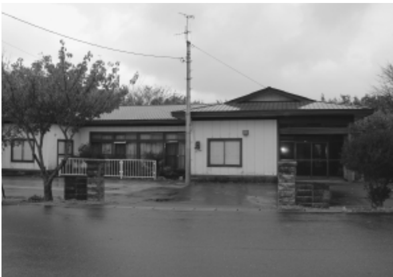
コミュニティセンター助成事業として、 鶏沢老人憩いの家の修繕工事を行う ※写真は工事前
