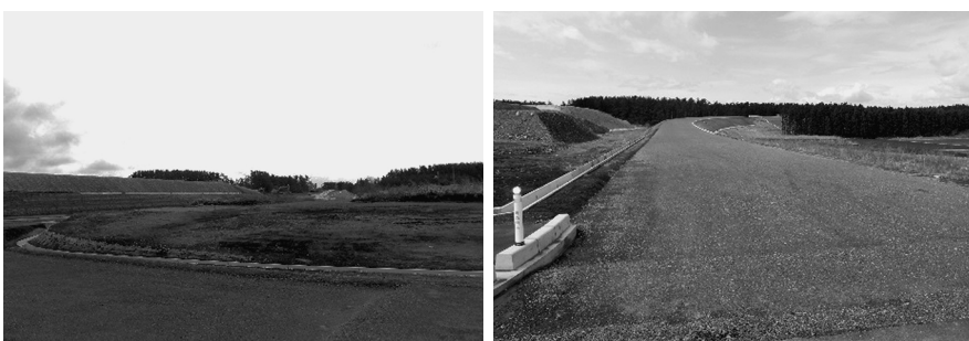
現在工事が行われている下北縦貫道（吹越バイパス）
