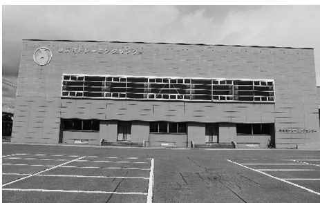
改修工事が行われる横浜町トレーニングセンター
