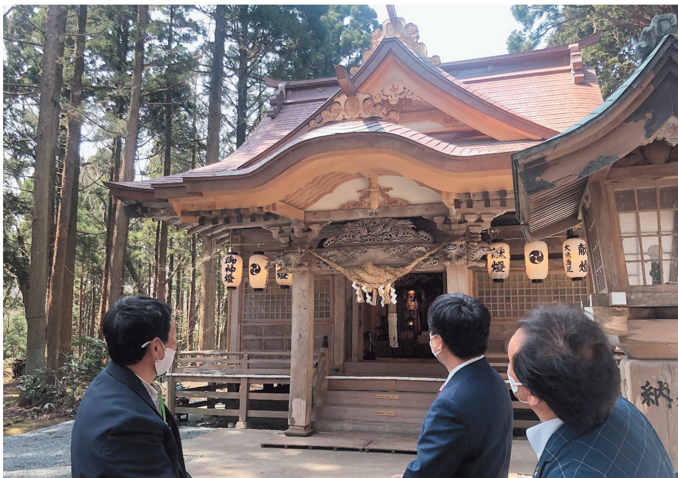
幣拝殿修繕工事で「千鳥破風」と「唐破風」が新しくなった八幡神社
