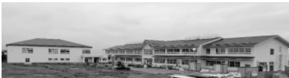
外壁の塗装が終わったことで、足場も外され、新横浜小学校が全貌を現しました。このあと、正面玄関の庇(ひさし)と校舎と体育館をつなぐ渡り廊下が取付けられます。
