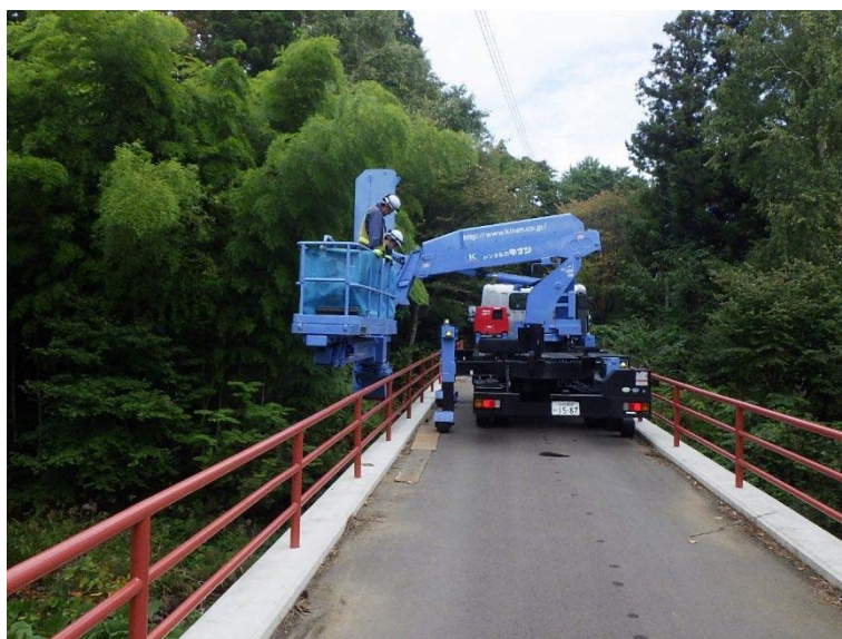
従来の点検方法（橋梁点検車）
