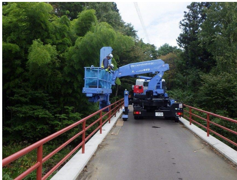
従来の点検方法（橋梁点検車）
