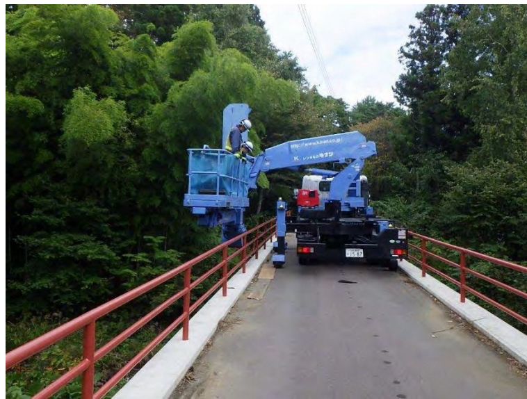
従来の点検方法(橋梁点検車)
